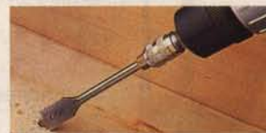
Drill a conduit opening
